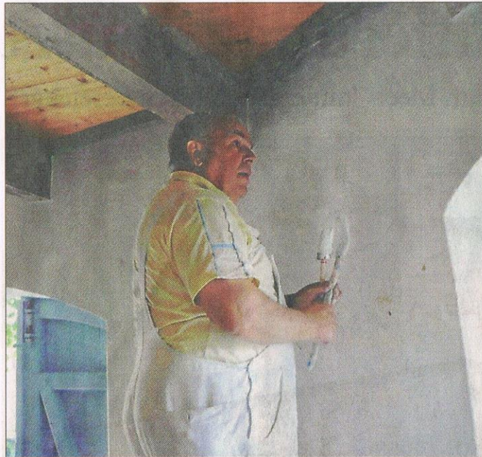
Ein Fachmann bei der Arbeit: Martin Ripken beim Streichen der Wände.
