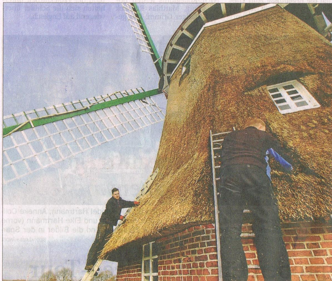
Dachdecker der Firma Röttger bei der Reetdachreparatur.
