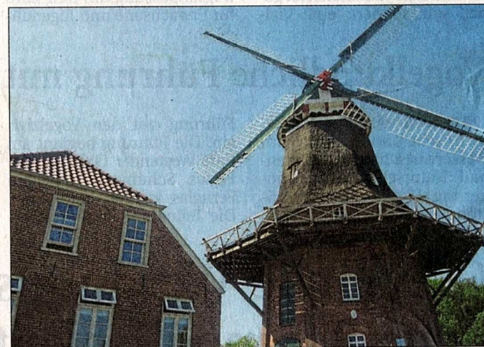
Die Renovierungsarbeiten am Müllerhaus sind beendet. Das wird am Mühlentag gefeiert.
