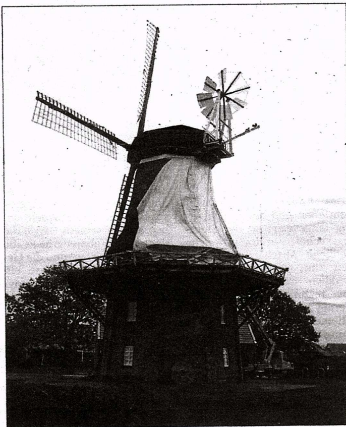
Die Nennendorfer Mühle ist vom Holzwurm befallen und soll mittels Begasung von den Parasiten befreit werden. FOTO: BURMANN
