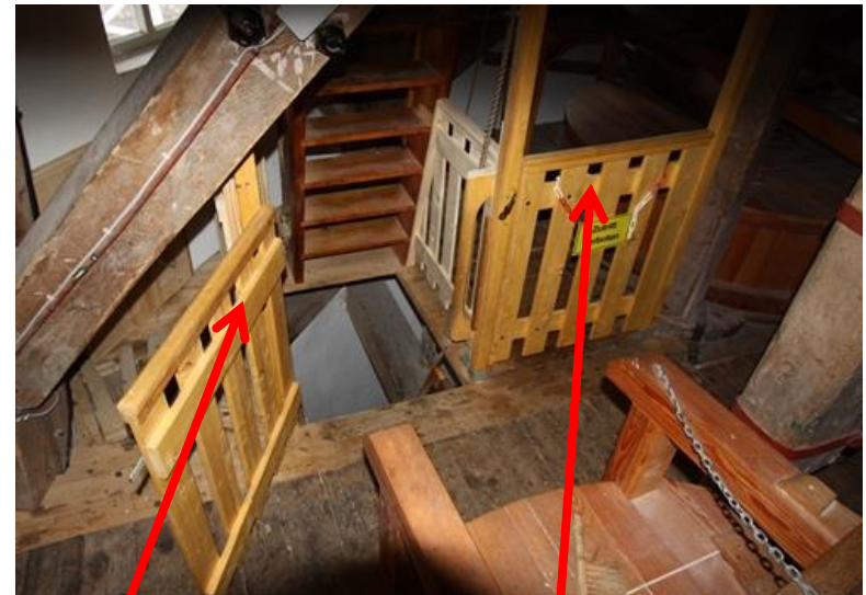
Absperrung Treppenloch Kappsöller
