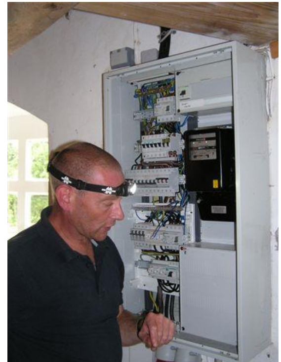
Überprüfung der elektrischen Anlage
